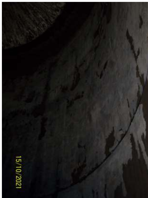
Fot.4,5,6. Wewnętrzna powierzchnia płaszcza zbiornika pozbawiona żywicy.
