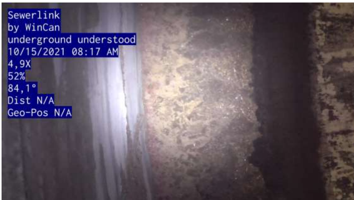
Fot.3. Styk górnego stożka komory z płaszczem.
