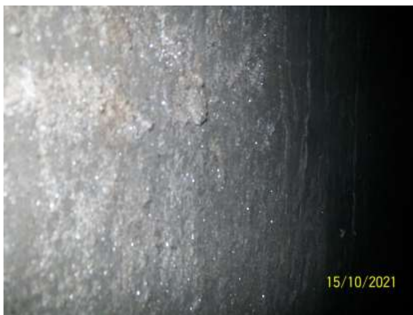
Fot.7,8. Pęcherze w miejscach odspojenia powłoki od betonu.
