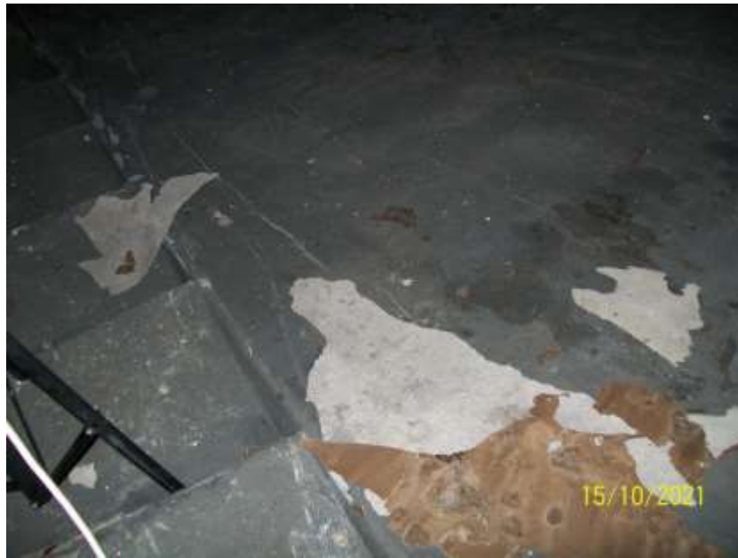
Fot.9. Fragmenty zniszczonej powłoki na powierzchni dna komory.
